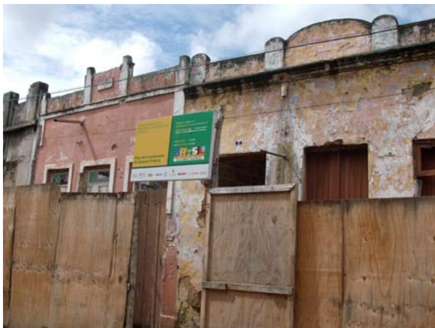
No dia 20/05/2008, a situação da reforma do imóvel, prevista para terminar em 11/05/2008 está retratada na foto. Fotos: Santos, C., 2008.
