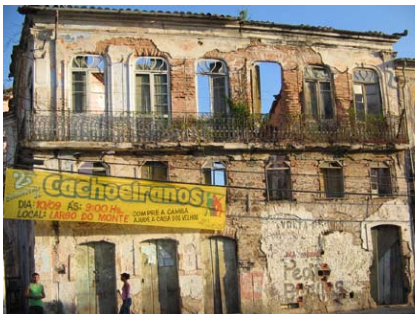
Imóvel na Praça da Aclamação em agosto de 2006.
