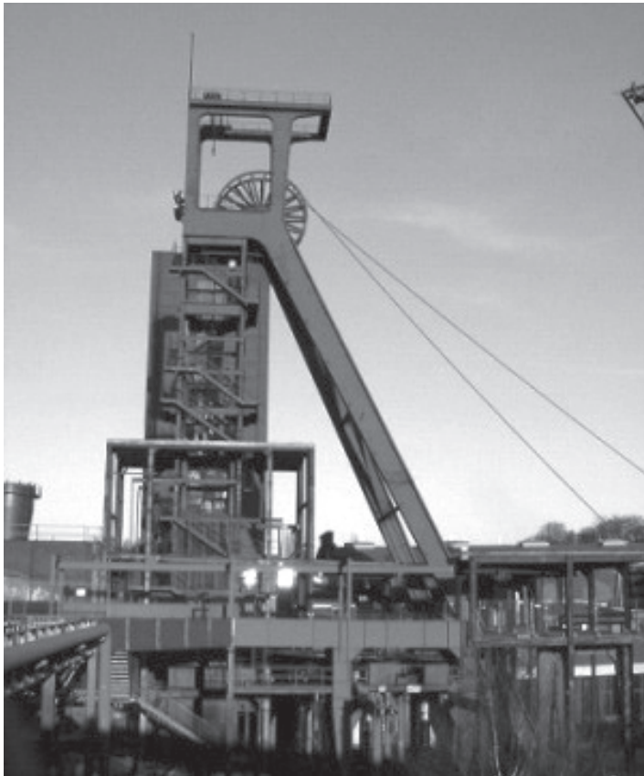
Figura 5 POÇO DE EXTRAÇÃO DE CARVÃO
