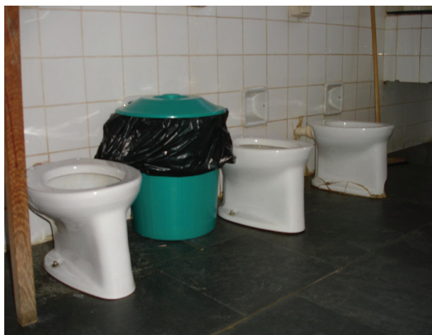
Figura 2 – O banheiro da creche. FONTE: arquivo pessoal.
