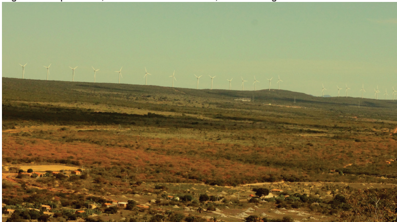
Figura 1: Parque Eólico, comunidade do Sumidoro, Vale da Mangabeira – Brotas de Macaúbas
