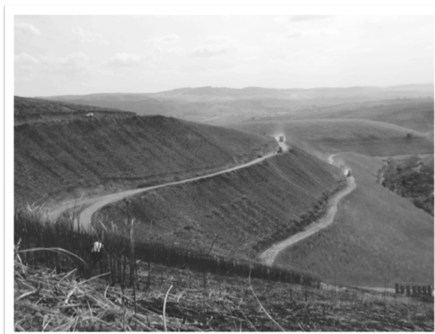
Figura 3 – Frente de corte manual nos morros em Ibateguara/AL
