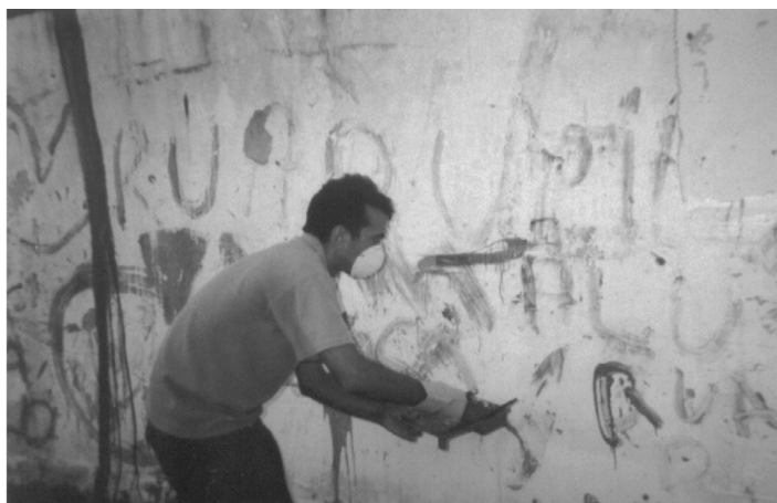
Figura 1 – Remoção da pele grafitada da superfície do muro Foto: MauricioCaribe/ 2004.
