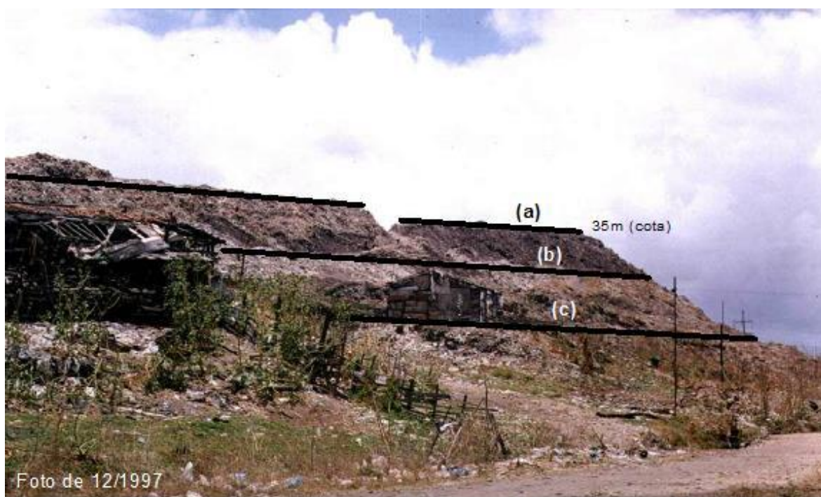
Figura 2. Estructuración escalonada pre-clausura del vertedero de Jangurussu. Los estratos a, b y c presentan distintas permeabilidades en función del grado de compactación de la basura.
