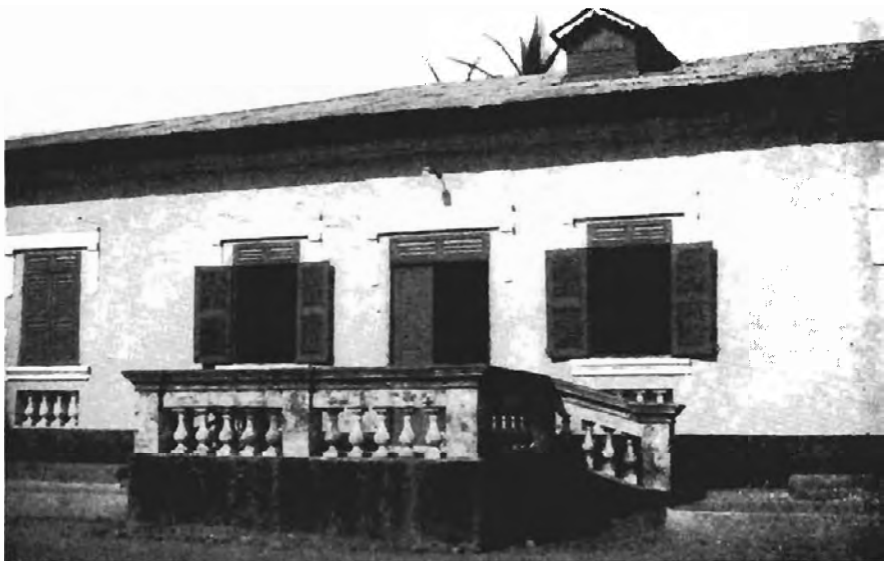
Fachada da casa de Chachá, célebre brasileiro de Uidá.
