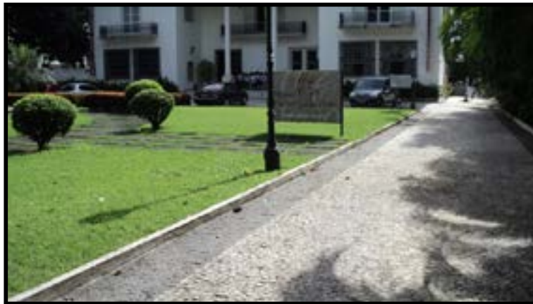
Figura 1 – Fachada frontal do Museu Carlos Costa Pinto (MCCP).
